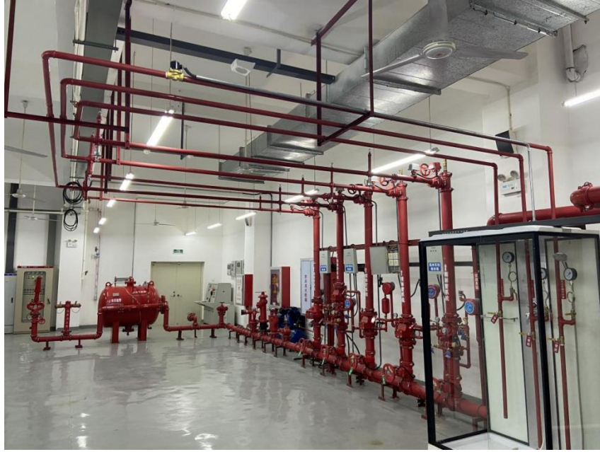
学院消防实训场地
